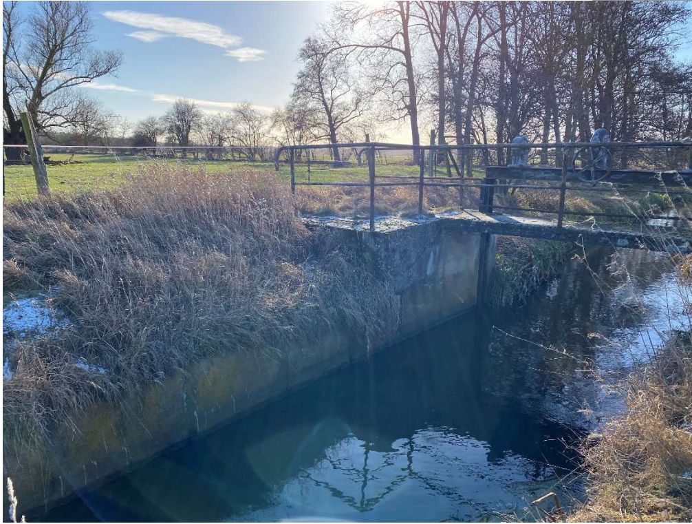
vorhandene Wehranlage – Station 1+545 – Blick von unterhalb
