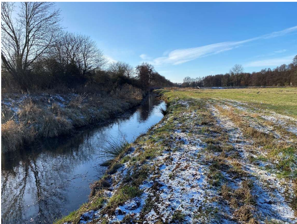
Blick zum Bauende – Brückenbauwerk im Zuge der L 53
