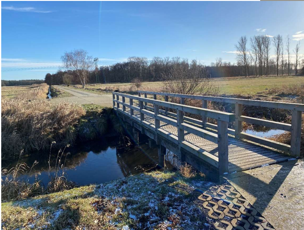
Fußgänger-/Radwegbrücke an Station 2+354 über den Dollgraben
