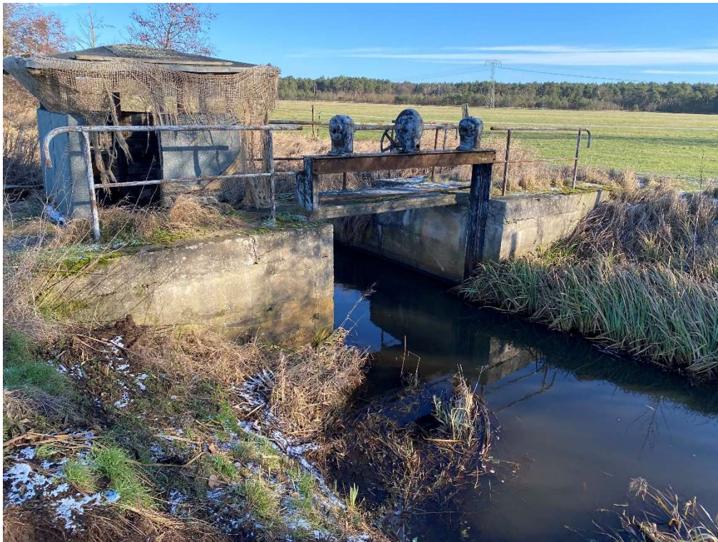
vorhandene Wehranlage – Station 1+545 – Blick von unterhalb
