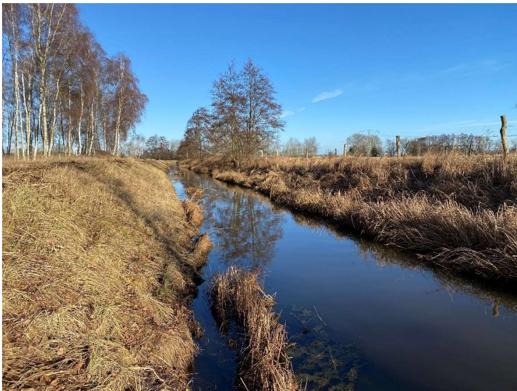
Station ca. 0+290 – Blick nach unterhalb
