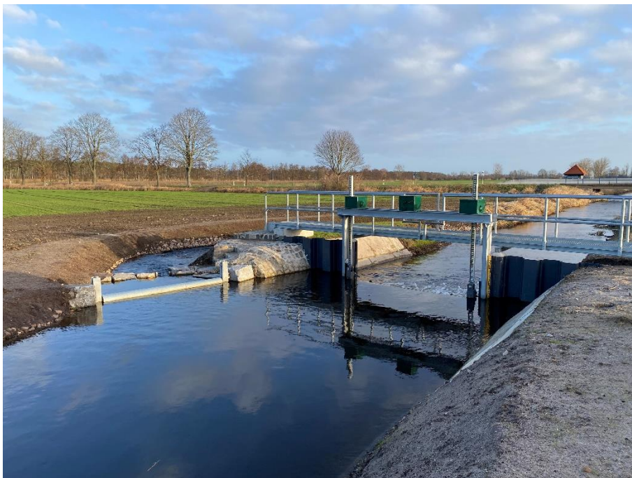
Wehr Schönwalde mit seitlicher Fischaufstiegsanlage
