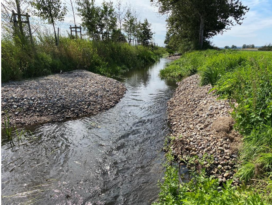
Sohl-Kiesschüttung im Gewässerlauf
